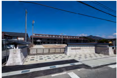
北広島島立壬生小学校 校舎棟
