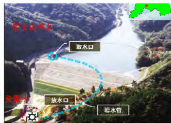
船上山発電所（鳥取県）・・・ダムの導水管を利用した小水力発電
