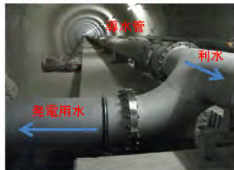
船上山発電所（鳥取県）・・・ダムの導水管を利用した小水力発電
