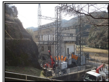
発電所鉄構 全景
