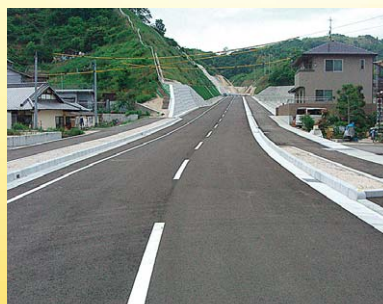
国道487号 小用バイパス(広島県内)
