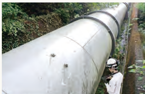
水圧鉄管調査
