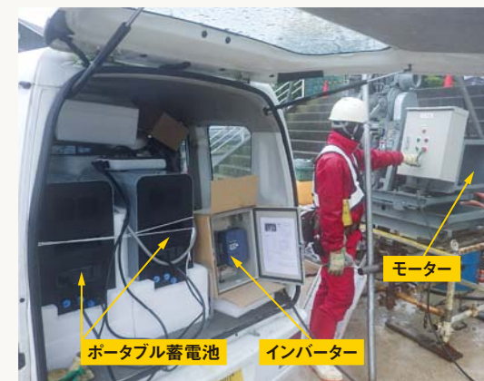
本技術によるボーリング調査状況
