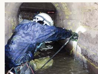
図1 導水路トンネル点検状況
