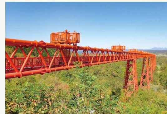
空港進入灯橋梁
