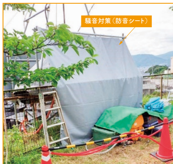
住宅地でのボーリング（騒音対策が必要）
