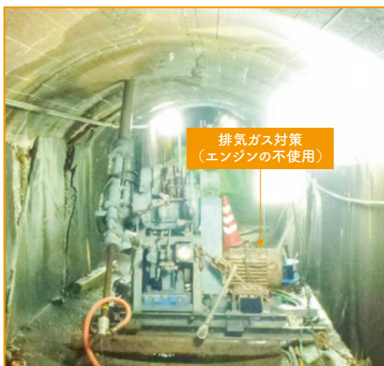
監査廊内でのボーリング（排気ガス対策が必要）
