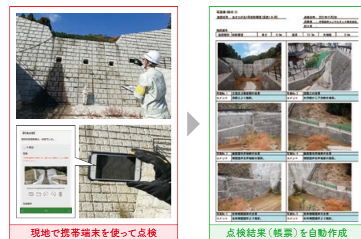
図2 「スマート調査」を用いた点検及び結果とりまとめの状況
