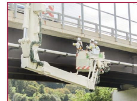
橋梁点検の様子
