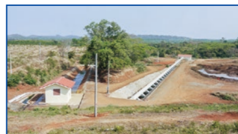
カンボジア小水力発電所
