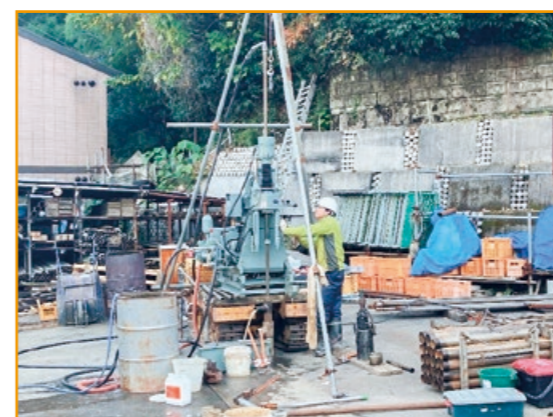
モーター搭載ボーリングマシン試掘作業
