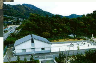
浄化センター
