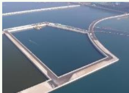
新南陽広域最終処分場
