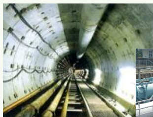
シールドトンネル
