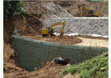
補強土壁による大規模盛土
