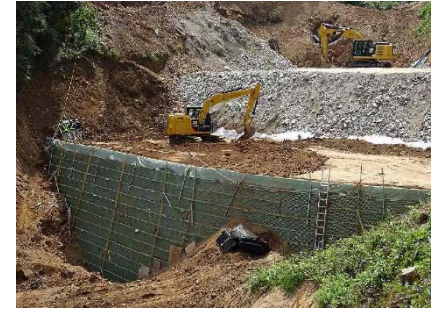
補強土壁による大規模盛土
