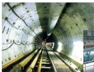
シールドトンネル
