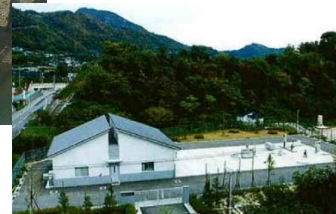
浄化センター
