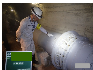
水圧鉄管外面調査
