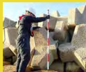
漁港海岸施設の点検風景
