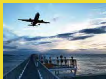
空港進入灯橋梁点検
