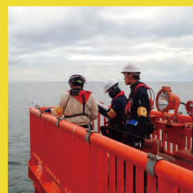
空港進入灯橋梁の点検風景
