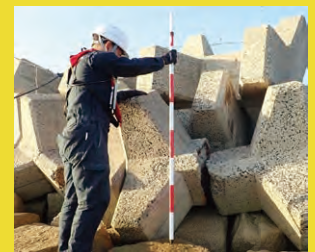
漁港海岸施設の点検風景
