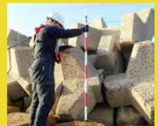
漁港海岸施設の点検風景
