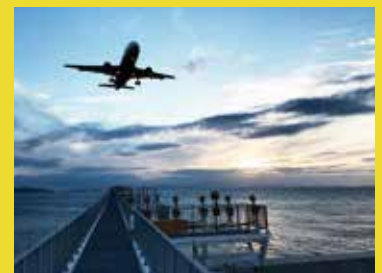
空港進入灯橋梁点検
