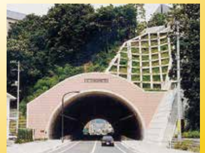
低土被り大断面トンネル（広島県内）
