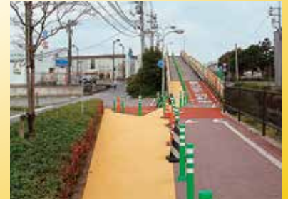
交通事故対策：米川歩道橋の安全対策検討(鳥取県内)
