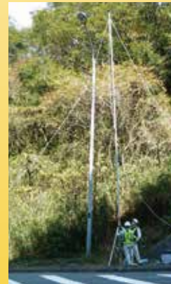
伸縮棒付きカメラによる 画像点検
