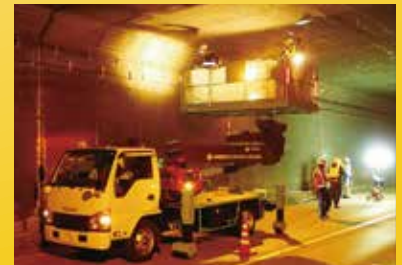
トンネル打音検査
