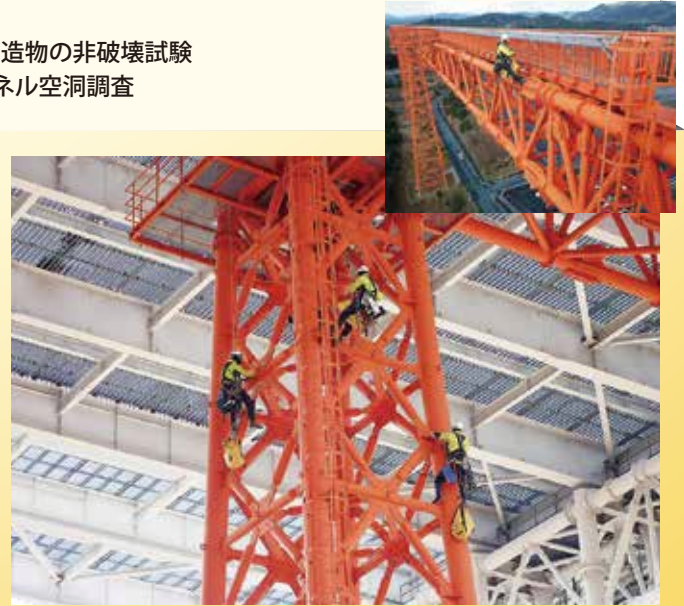
高所ロープ点検
