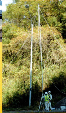
伸縮棒付きカメラによる画像点検
