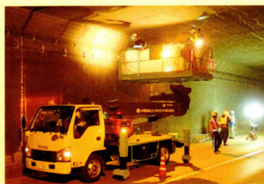
トンネル打音検査(※高所作業車新規配備)
