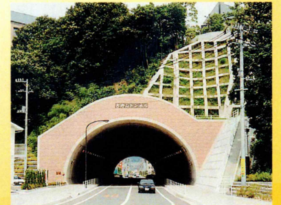
低土被り大断面トンネル（広島県内）
