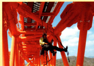
高所ロープ点検
