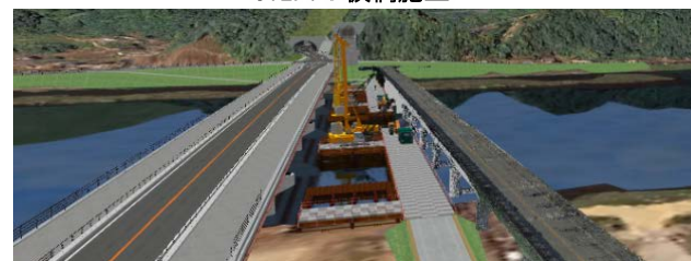
STEP2：下部工施工
