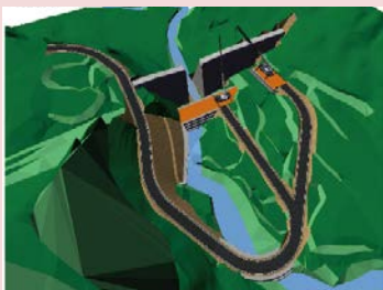
砂防堰堤のCIM統合モデル
