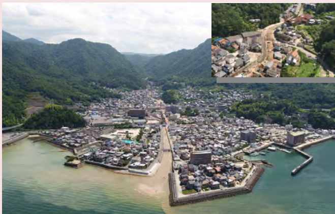
災害後の状況調査（2018年7月，広島）
