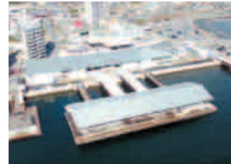
宮島口フェリー乗り場 棧橋屋根（広島県廿日市市）（広島県提供）
