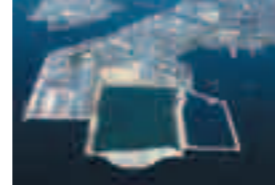
出島廃棄物処分場
