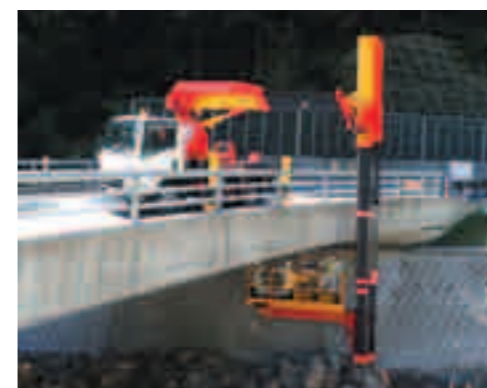
橋梁点検車による点検
