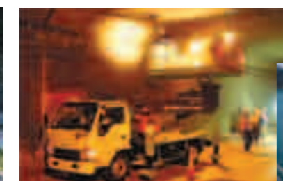
トンネル打音検査
