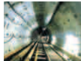
シールドトンネル
