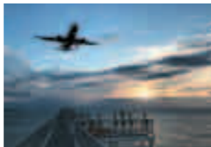
空港進入灯橋梁
