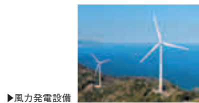
▶風力発電設備
