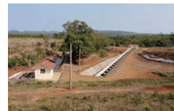
新設水力発電所 (カンボジア)
