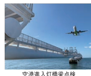
空港進入灯橋梁点検
