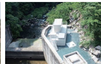
新設水力発電所 (島根県)
