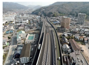
東広島バイパス（国道2号）
