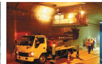
トンネル打音検査
