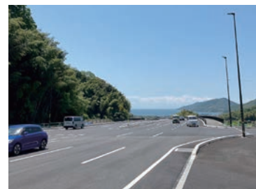
富海拡幅（国道2号）
