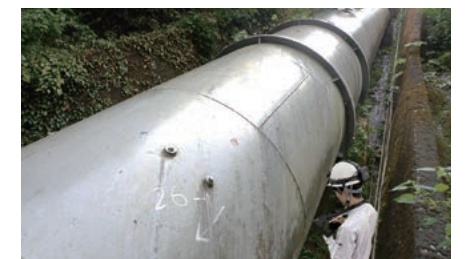
鉄管点検・調査
