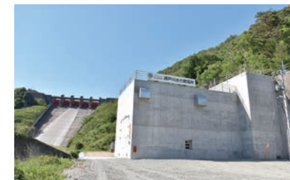
新設水力発電所 (福島県)
