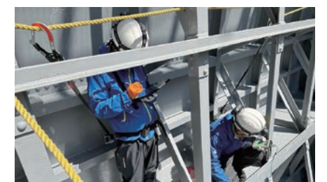
ゲート点検・調査
