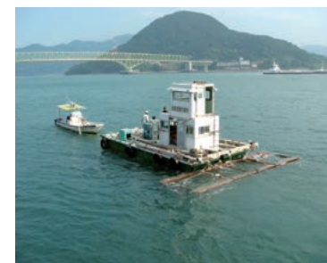
磁気探査状況
