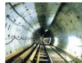
シールドトンネル
