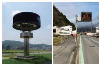
河川・道路情報表示設備
