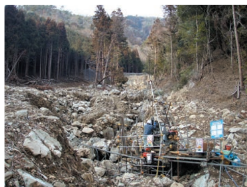
砂防堰堤の地盤調査
