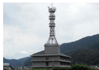
多重無線設備
