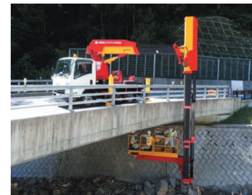
橋梁点検車による点検
