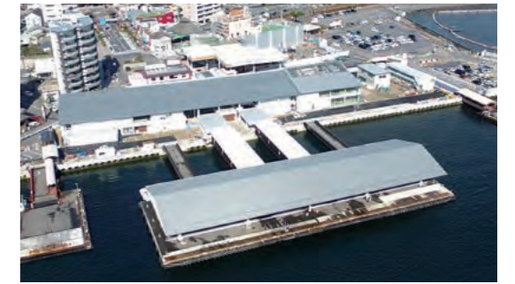
宮島口フェリー乗り場橋屋根(広島県廿日市市)
