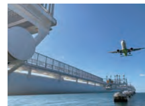
空港進入灯橋梁点検
