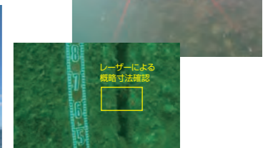
水中ドローンによる水中構造物の確認
