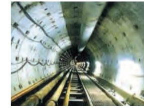
シールドトンネル
