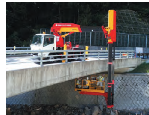
橋梁点検車による点検
