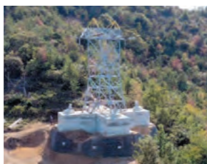
鉄塔基礎の補強設計
