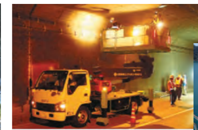
トンネル打音検査
