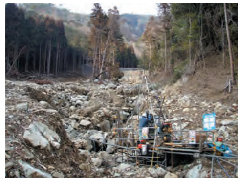
砂防堰堤の地盤調査
