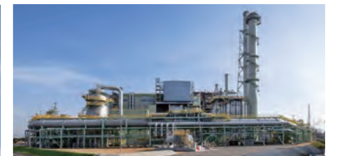
瀬戸内共同火力(株)福山新2号機(広島県福山市)
