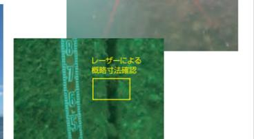
水中ドローンによる水中構造物の確認
