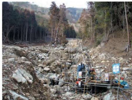
砂防堰堤の地盤調査
