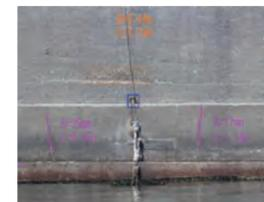
画像解析による劣化・損傷の抽出
