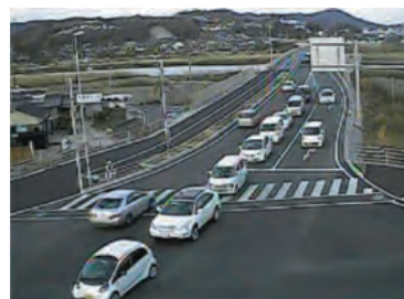
国道188号 岩国南バイパス（山口県内）
