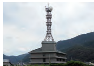
多重無線設備
