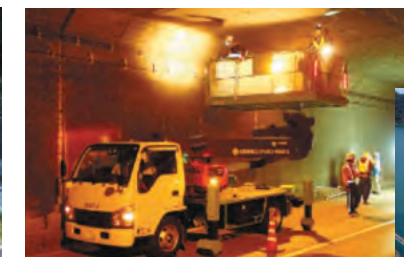
トンネル打音検査
