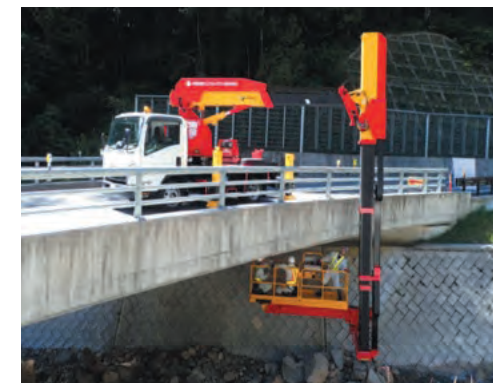
橋梁点検車による点検
