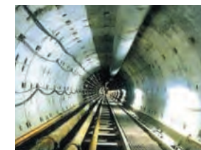
シールドトンネル
