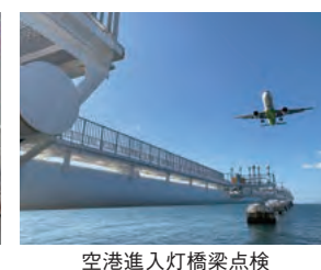
空港進入灯橋梁点検
