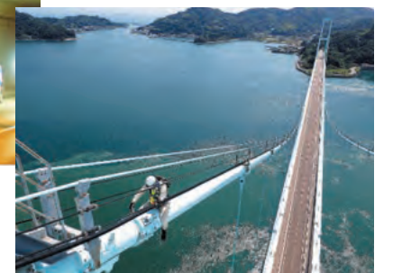
長大橋点検作業
