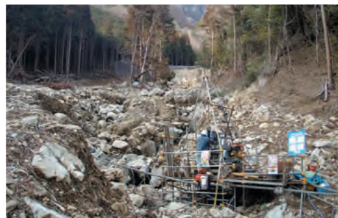
砂防堰堤の地盤調査
