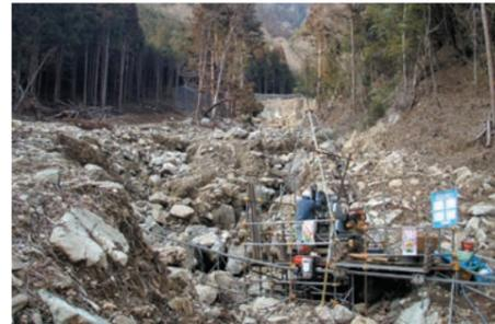
砂防堰堤の地盤調査
