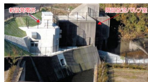
既設灌漑用ダムを有効利用した新設発電所水力発電所計画・設計
