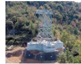
鉄塔基礎の補強設計
