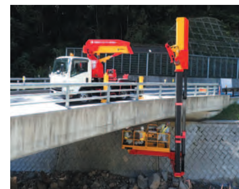
橋梁点検車による点検
