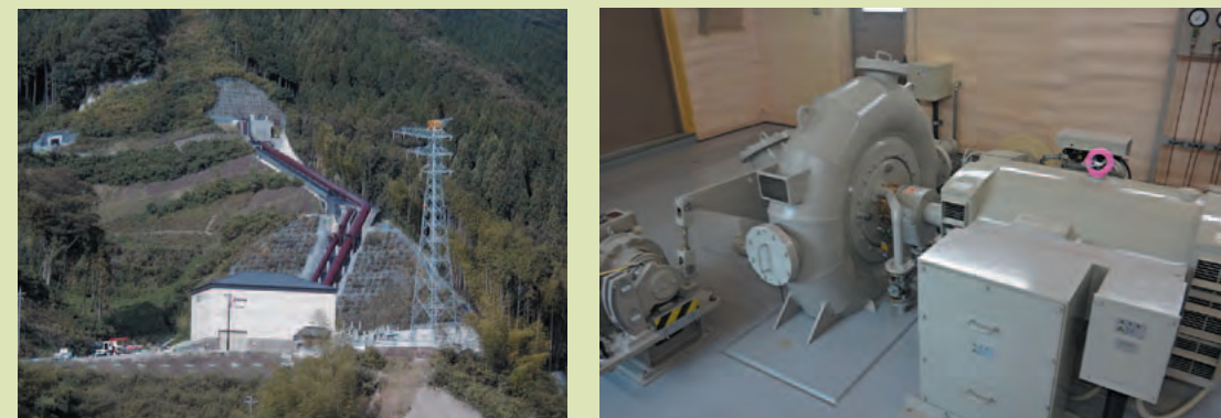
水力土木部門と連携し、最適な形式・効率の水車・発電機を設計
