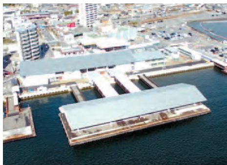
宮島口フェリー乗り場 棧橋屋根（広島県廿日市市）（広島県提供）
