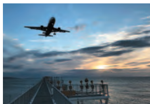
空港進入灯橋梁
