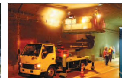
トンネル打音検査
