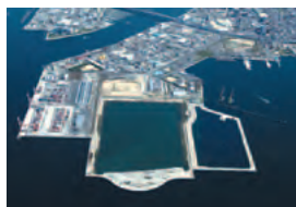
出島廃棄物処分場
