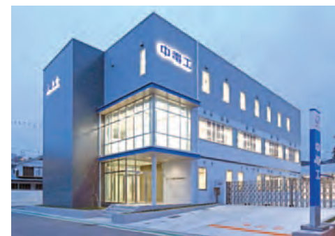
株式会社中電工 廿日市営業所（広島県廿日市市）
