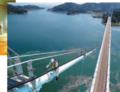
長大橋点検作業
