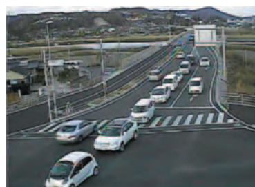
国道188号 岩国南バイパス (山口県内)
