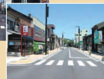
道路部門と連携し、電線類（配電設備）の無電柱化手法を提案・設計
