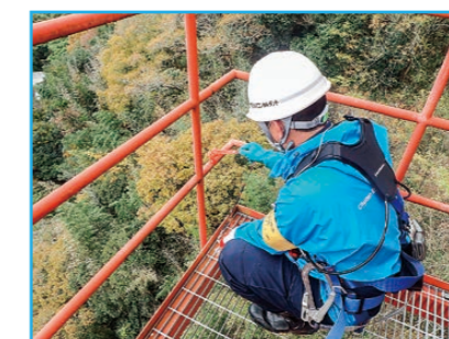
タッチアップの作業状況
