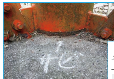
橋脚地際部滞水処理法の提案例
