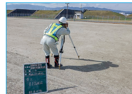
施工状況確認の様子 (工事監理業務)
