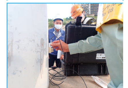
橋脚基部の非破壊試験 (IB NETIS: CB-110028-VR)
