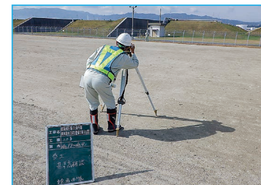
施工状況確認の様子 (工事監理業務)
