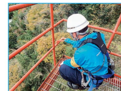
タッチアップの作業状況
