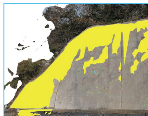
写真・赤外線画像から作成した損傷図
