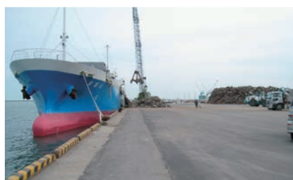
宮城県石巻港(撮影: 中電技術コンサルタント(株))
