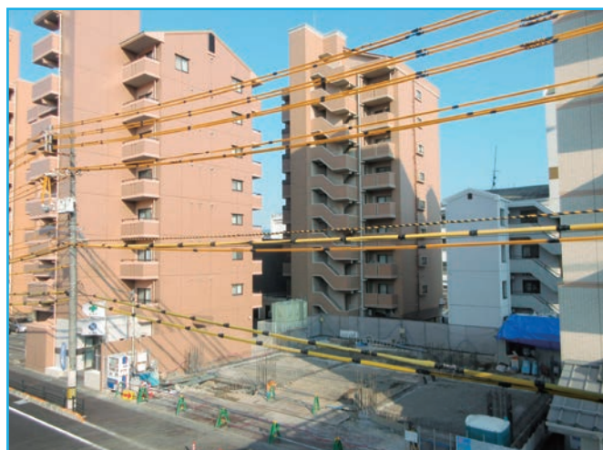
工事現場での架空線防護状況
