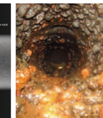
同左 腐食状況 (内面目視)
