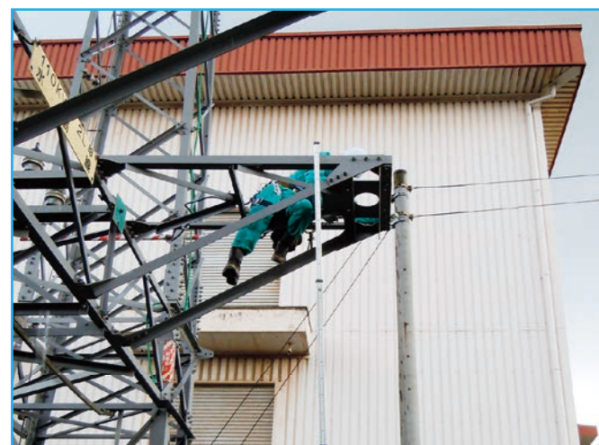
現状の変電所鉄構上での昇塔作業風景
