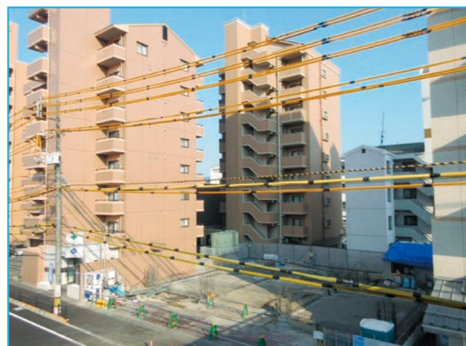
工事現場での架空線防護状況
