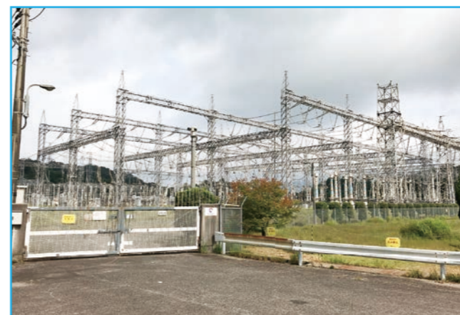
特別高圧変電所遠景
