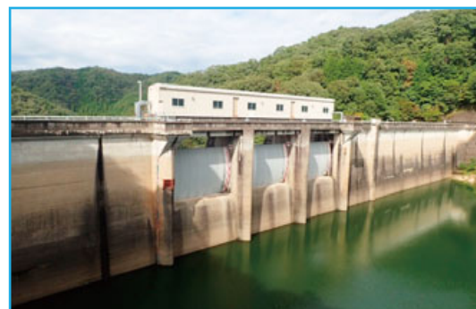
水力発電所におけるゲート設備
