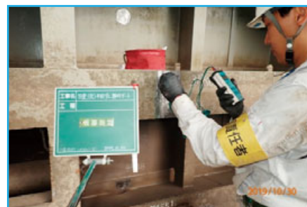
板厚測定状況
