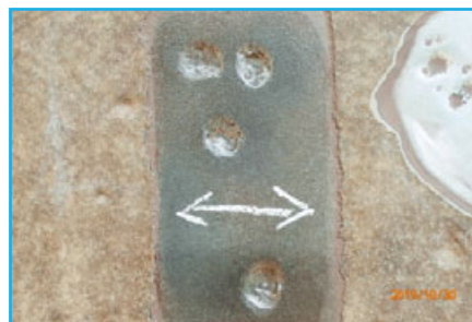
鋼材の腐食面
