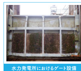
水力発電所におけるゲート設備
