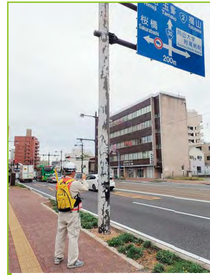
システムを用いた点検状況
