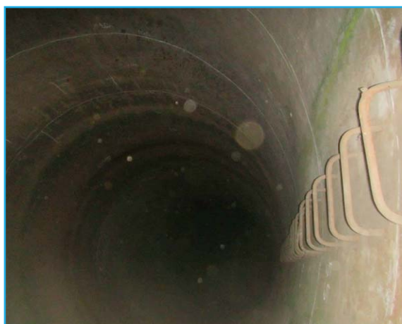
サージタンク内部 (日常点検では暗くて、劣化状況が見えない)
