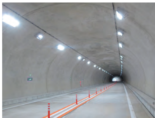
LED照明器具によるトンネル 〔中国横断自動車道尾道松江線 別迫トンネル〕
