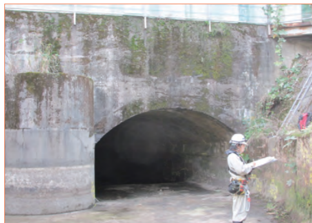
水路トンネル調査
