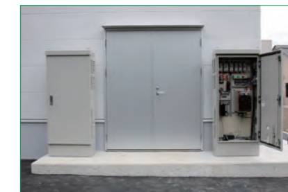
切替制御装置 SW-BOX(植物工場前)
