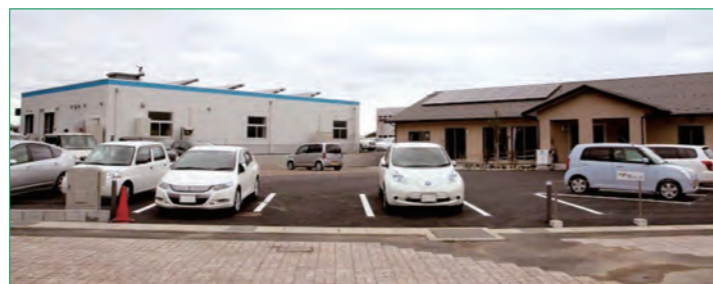
実証エリアの状況
