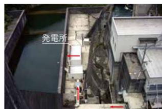
既設ダムに設置した維持流量発電所
