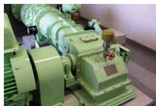
浄水場の減勢施設に設置したクロスフロー水車
