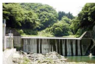
砂防堰堤を取水ダムに利用
