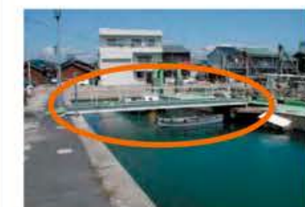
図4. 浮き桟橋への連絡橋(渡橋)
