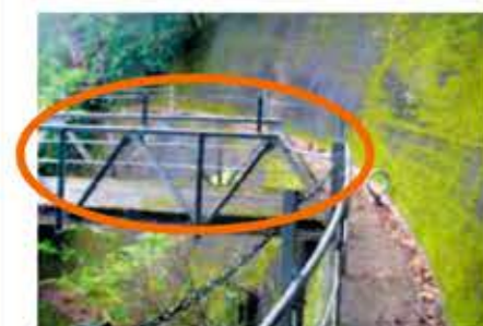
図1. サージタンク天端への連絡橋
