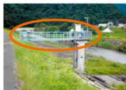
図2. 樋門の連絡橋
