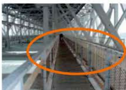
図3. 海洋架橋の点検通路
