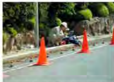
盛土範囲を把握するための表面波探査
