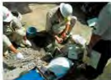
地下水位観測孔の設置
