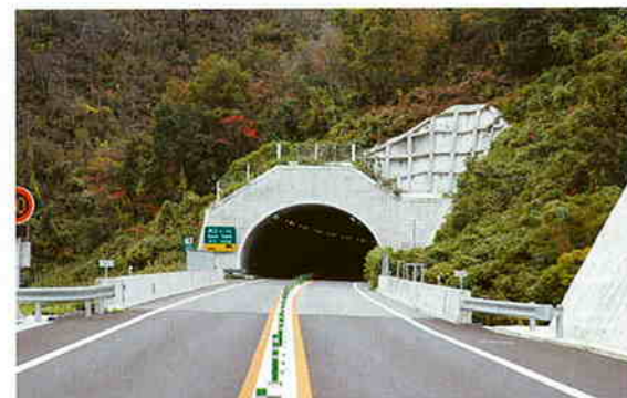
洲江トンネル坑口付近
