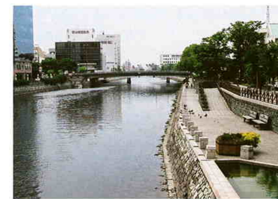
新町川河岸整備
