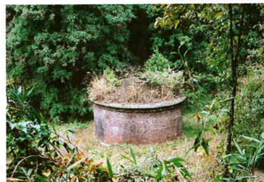
男達の闘いの跡(第1号トンネル工事用堅坑)
