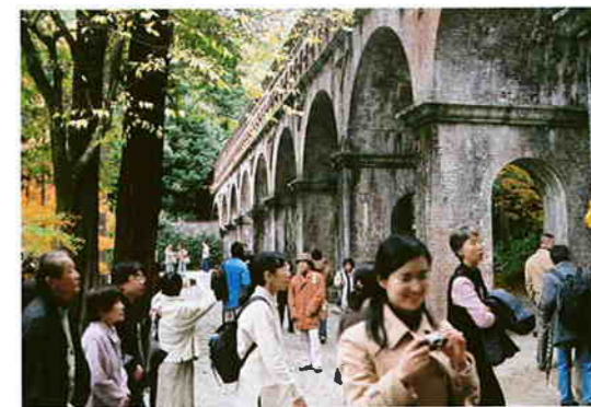
疏水分線 南禅寺水路閣
