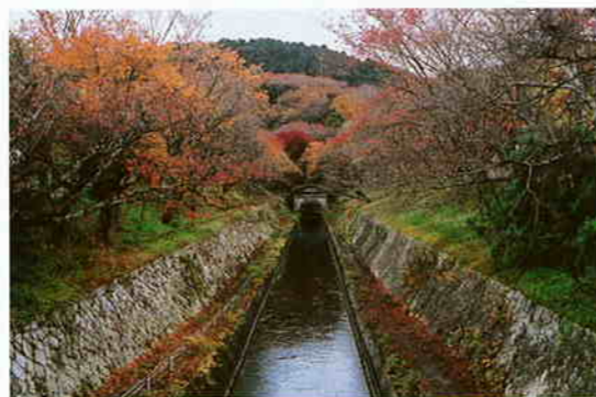
1号(長等山)トンネルへ続く疏水
