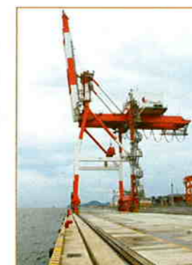
そびえ立つ ガントリークレーン
