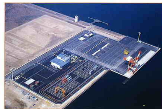
福山港国際コンテナターミナル 全景
