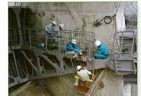
ダムゲート(ラジアル)脚柱フランジの 応力測定状況
