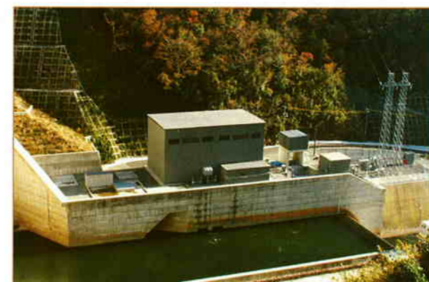
苫田発電所他(ダム減勢工左岸部)
