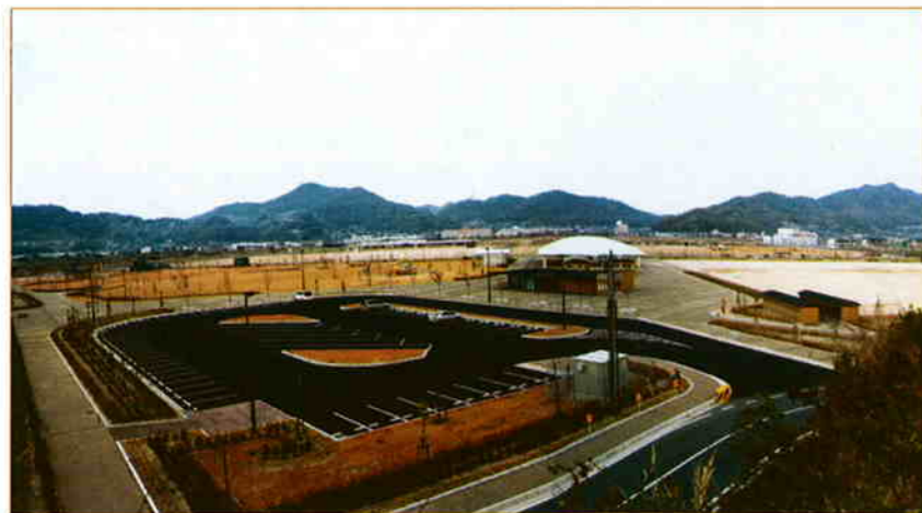
三山スポーツ公園 全景
