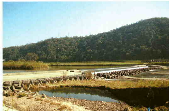
久松床固工 全景
