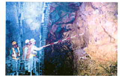
トンネル切羽地山判定
