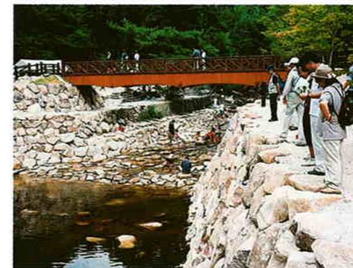
水分峡で進む砂防環境整備
