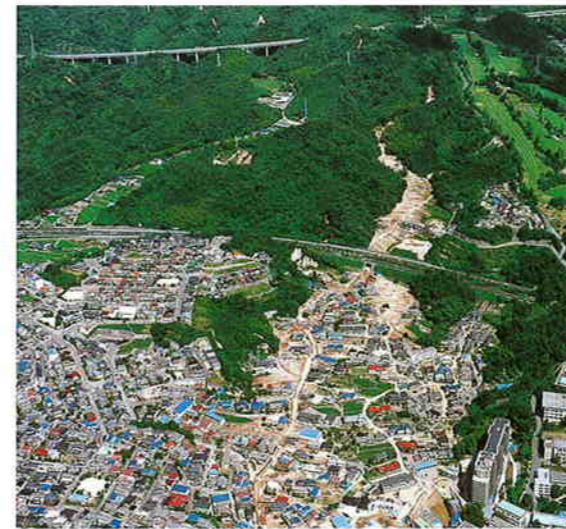
写真：屋代川被災状況 広島市佐伯区 死亡：1名、建物被害：全壊8戸、半壊14戸
